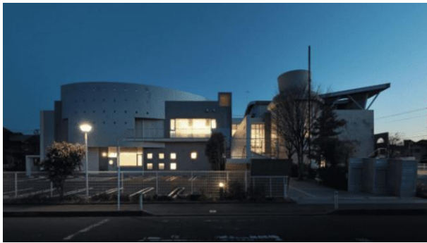
GAMBAR 1. FASAD BANGUNAN EKSTING (ARCHELLO, 2021)
