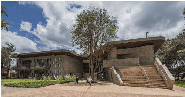
GAMBAR 1. FASAD BANGUNAN EXISTING (ARCHELLO, 2023)
